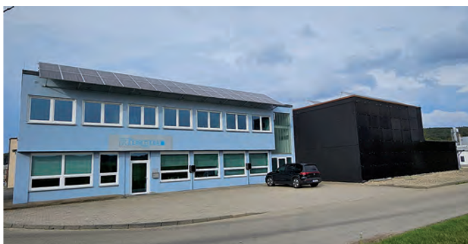
Solarmodule an der Südseite des Betriebsgebäudes in gekippter Anordnung (links) sowie senkrecht als aufgesetzte Außenfassade (rechts)
