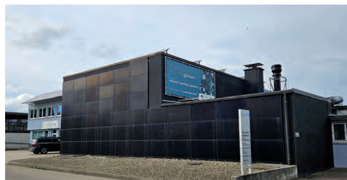
Solarmodule an der Südseite des Betriebsgebäudes in gekippter Anordnung (links) sowie senkrecht als aufgesetzte Außenfassade (rechts)
